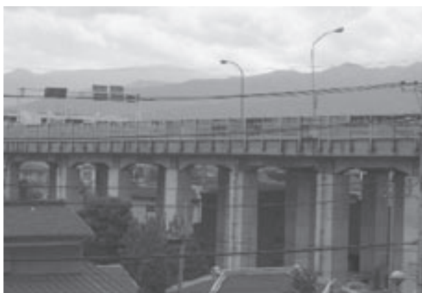
①国道255号（松田高架橋）耐震補強
