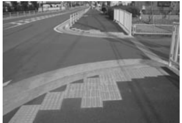
⑰県道 78 号（御殿場大井）バリアフリー化
