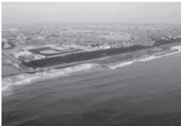
②茅ヶ崎海岸消波堤整備
