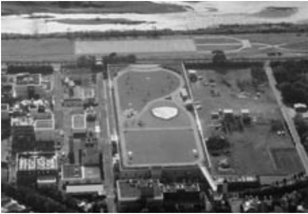
⑭酒匂川流域下水道左岸処理場機械濃縮棟増築
