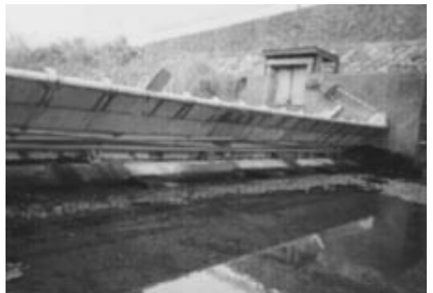
⑦万年堰地区取水堰整備
