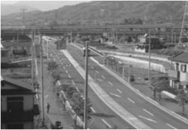
⑨小田原環状道路整備
