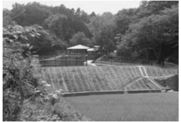
⑥寺家地区ため池改修
