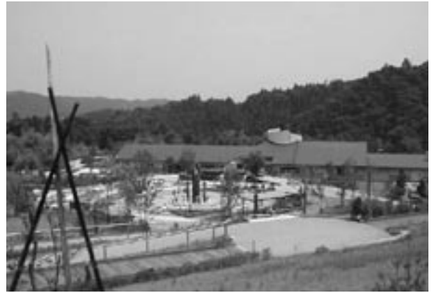
⑮県立あいかわ公園整備
