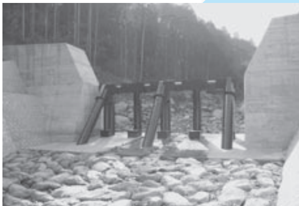
③唐沢川餅搗場えん堤整備
