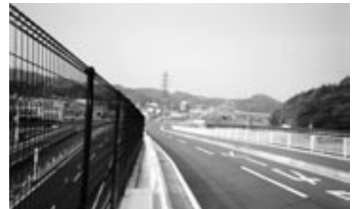
国道1号(小田原箱根道路)
