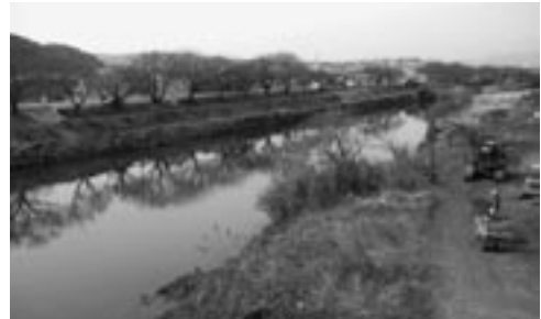
多自然型護岸整備（金目川）
