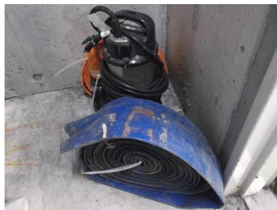
排水ポンプの準備
