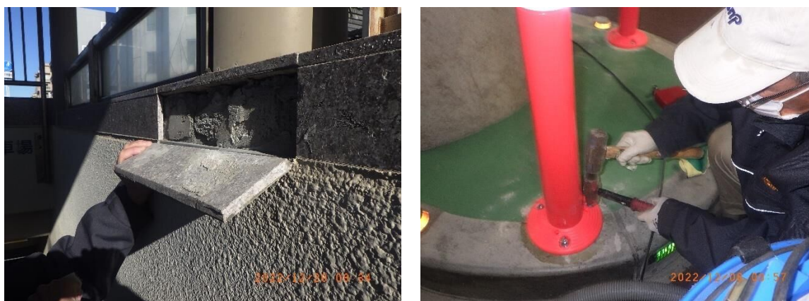
直営修繕チームによる修繕（左：階段ブロック落下防止 右：ポール設置）
