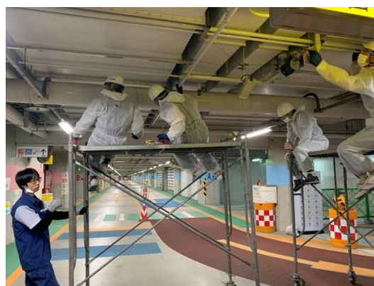
場内の粉塵除去作業
