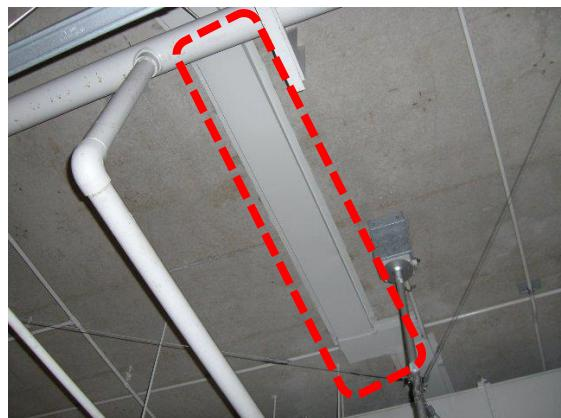
図 招き灯の交換（左）、排水版の設置（右）
