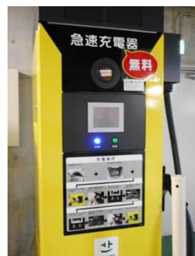
図 整備したEV車急速充電器
