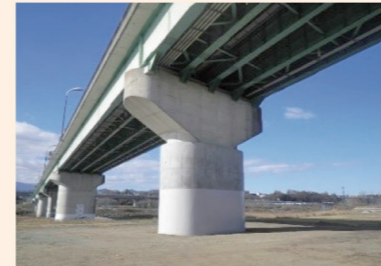
① 橋脚の補強
