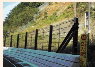
② 落石・土砂崩落対策
