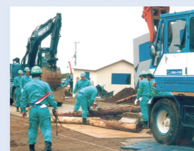
道路啓開・復旧訓練
