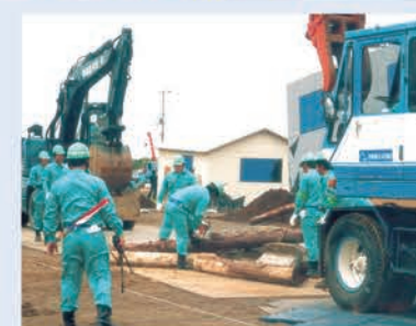
道路啓開・復旧訓練
