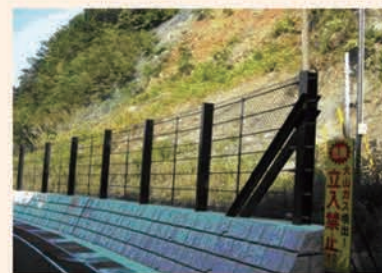
② 落石・土砂崩落対策
