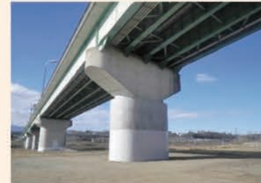
① 橋脚の補強
