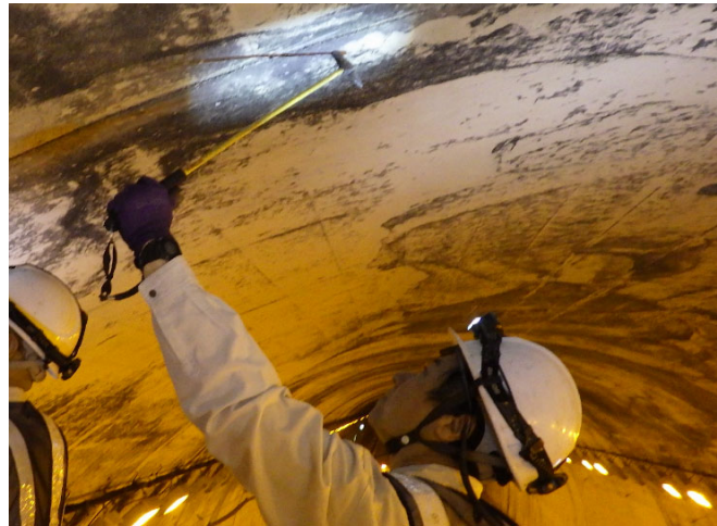
(a) トンネル本体工
