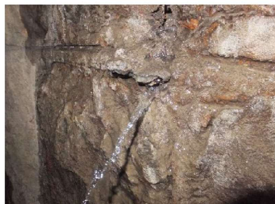
付写真-1.7 漏水（噴出）している例
