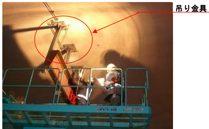
写真－解 3. 3 触診作業状況
