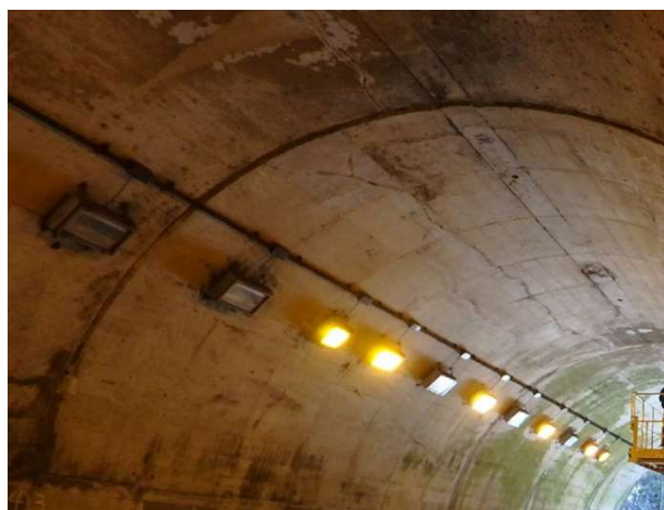
付写真-1.3 覆工の天端付近に発生した縦断方向のひび割れの例
