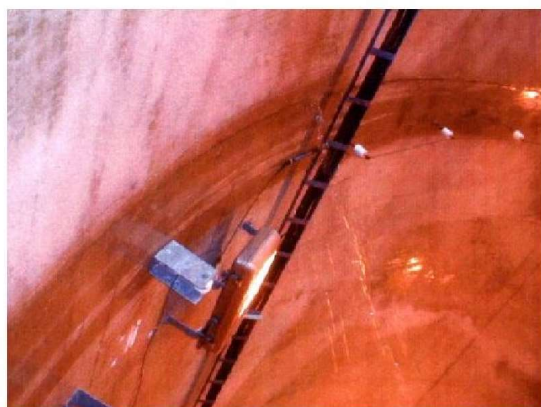
付写真-1.7 漏水（噴出）している例
