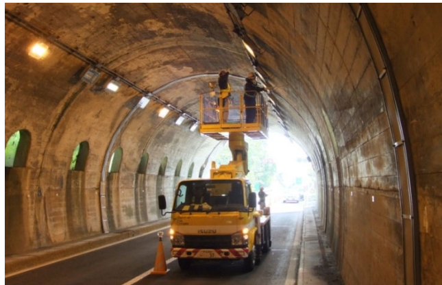
写真一解 3. 1 近接目視作業状況
