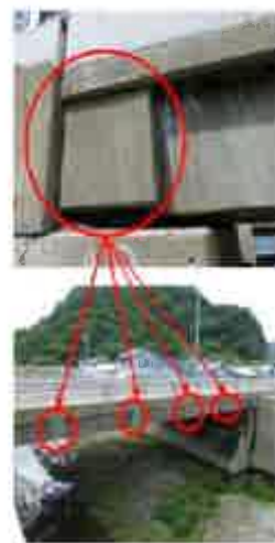
覆水切りが桁下まで打ち下ろさないため、横桁位置が確認する。
