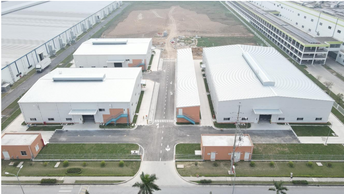
第三タンロン工業団地の貸工場区画(一部)外観
