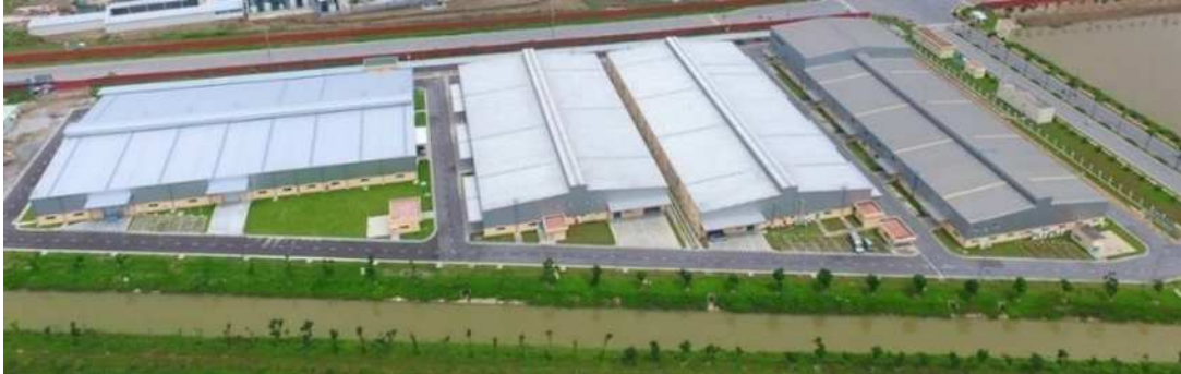
第二タンロン工業団地の貸工場区画(一部)外観
