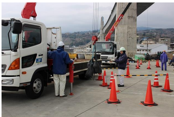
小型クレーンの実技講習の様子
