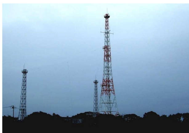
図4 送受信所の撤去工事完了後 鉄塔は3本のみ残り空中線もほとんど撤去 (2015年10月1日撮影)
