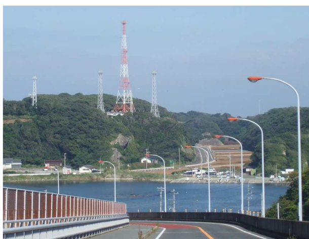
図1 毘沙門バイパスから見た旧受信所の鉄塔群 撤去工事前(2015年8月26日撮影)
