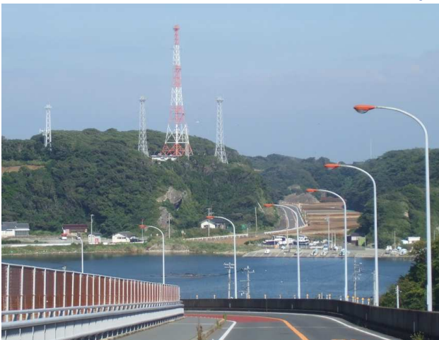
撤去前の旧受信所の鉄塔群
