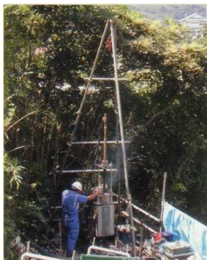
図 1-2-5 ボーリング調査の作業状況
