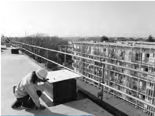
屋上防水工事
