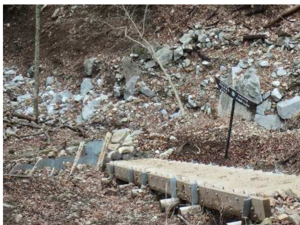
6年前の階段工の様子
