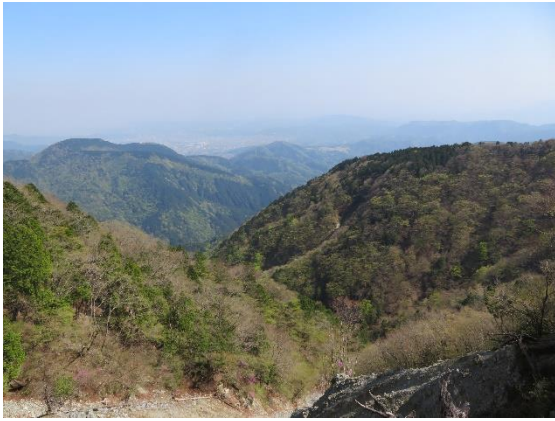
写真7：崩壊地からの展望
