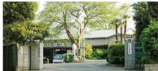
東洋内燃機工業社 本社
