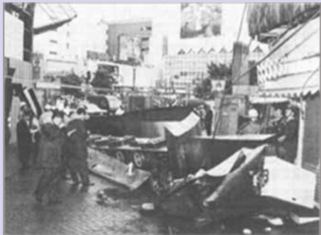
台風で落下した時の様子
