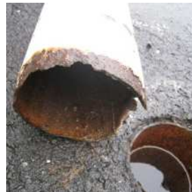
ポール看板の倒壊
