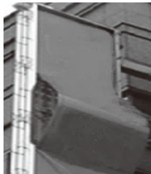
盤面のズレや取付具の欠落は落下の前触れ。
