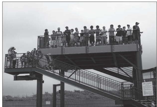
(写真2) 県立湘南海岸公園・津波避難施設
