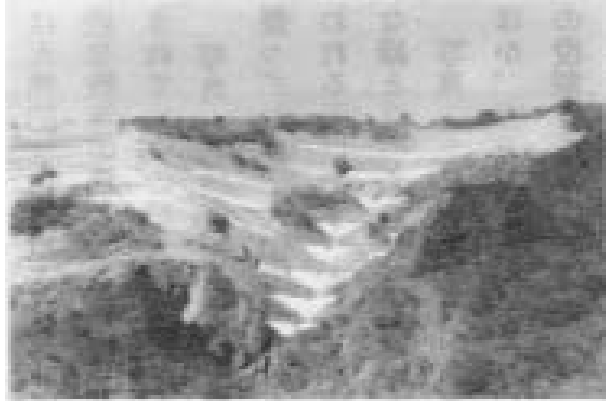
写真一 三ノ塔の山腹復旧工事施行跡
