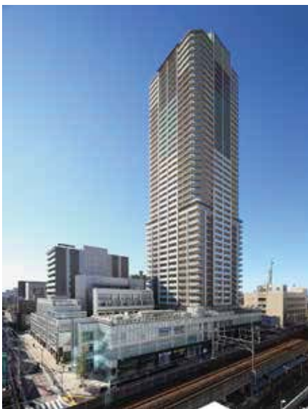
建設中の新東名高速道路、リニア中央新幹線、小杉町3丁目中央地区市街地再開発事業
