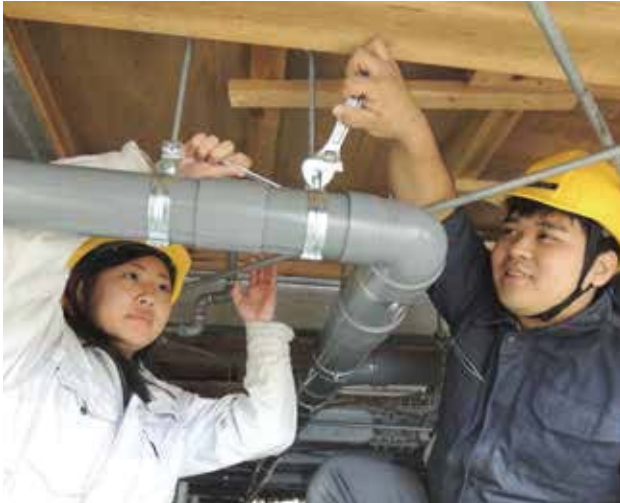
建物施工の職業訓練の様子
