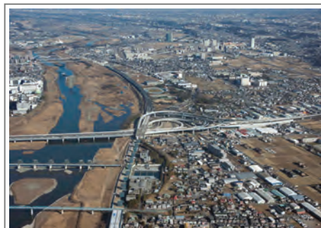
建設中のさがみ縦貫道路
