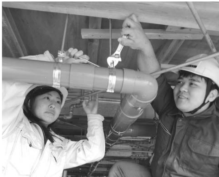
建物施工の職業訓練の様子
