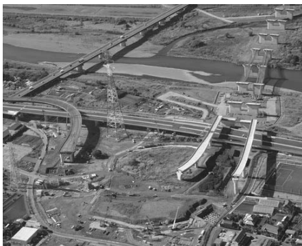
建設中の新東名高速道路
