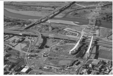
建設中の新東名高速道路
