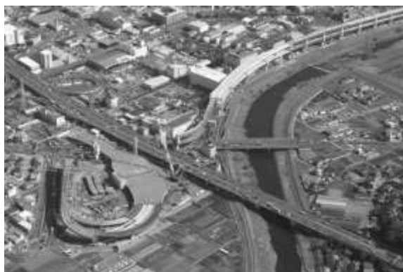
高速横浜環状北線 港北JCT
