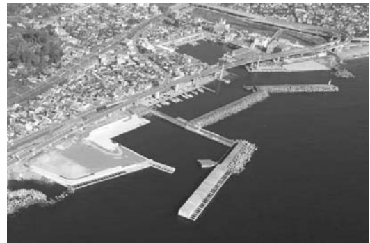
整備が進む小田原漁港
