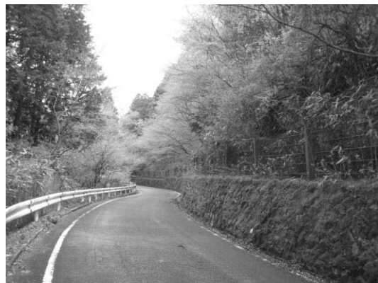
南足柄市と箱根町を連絡する道路の整備
