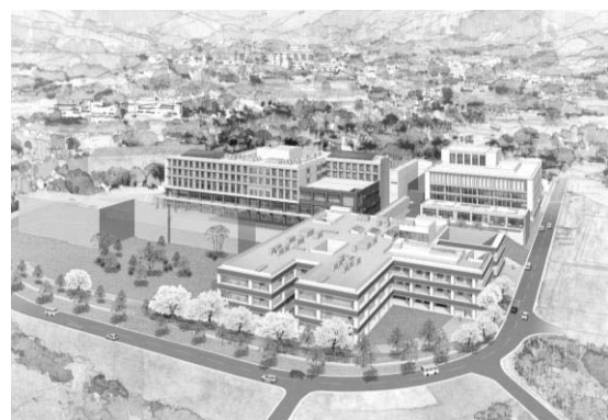
再整備後の総合リハビリテーションセンター
