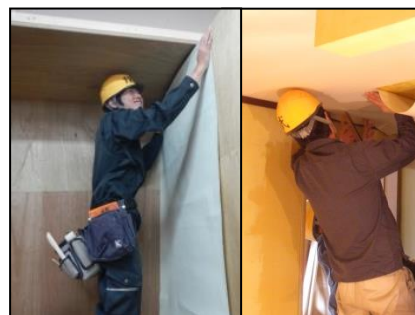
内装施工 (壁装)
