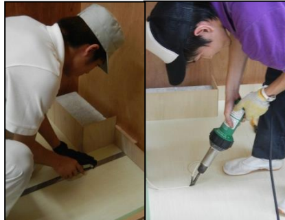
内装施工 (床仕上げ)
