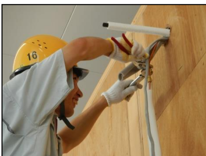
エアコン工事
