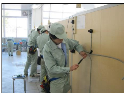
電気工事実習
