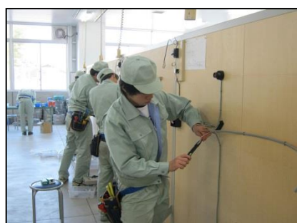
電気工事実習
