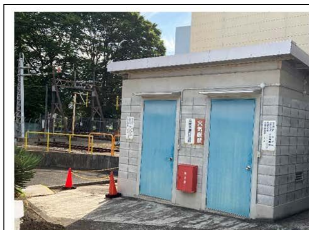
写真 5-2-15-1 危険物屋内貯蔵所
