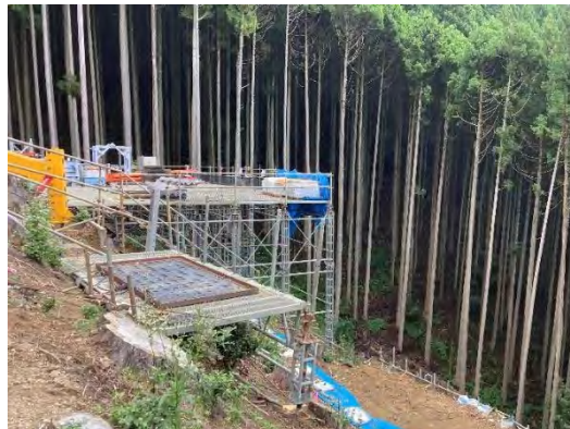
仮設ステージ（作業構台）の準備
