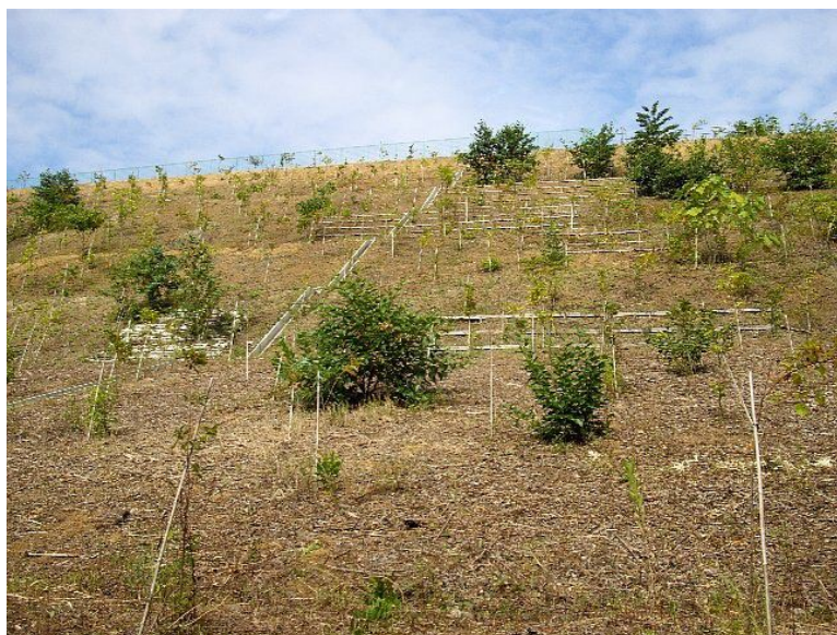
図 3-6 緑化実施後の平成 21 年度の法面の状況（平成 21 年 9 月 7 日）
