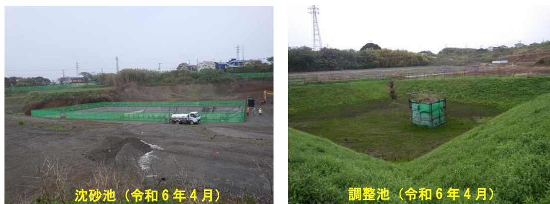
図 2-2 環境保全対策の実施状況（左：沈砂池、右：調整池）
