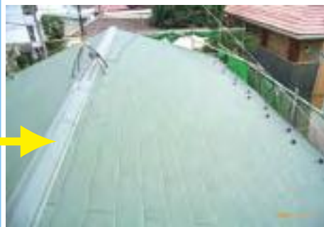
耐震改修(屋根の軽量化)
