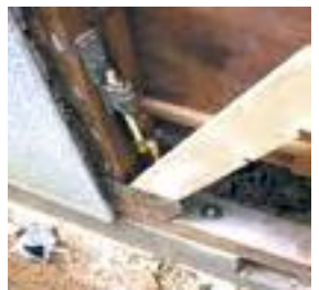
耐震改修(筋かい補強)
