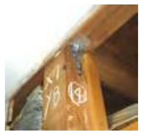
耐震改修(接合部の補強)
