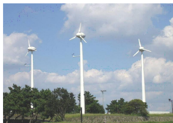
図 1.1.4 風力発電設置例（川崎市浮島町公園）
