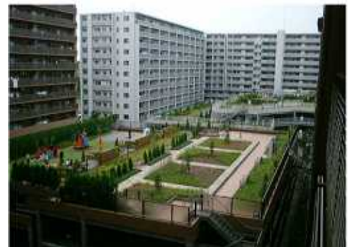
図 4.2.3 民間マンションにおける事例（神奈川県川崎市）
