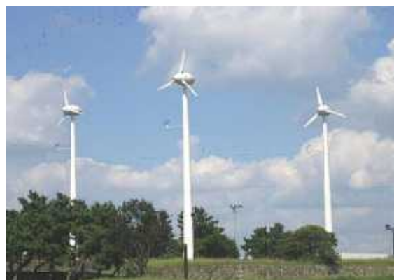
図 1.1.4 風力発電設置例(川崎市浮島町公園)
