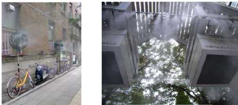
図2.2.4 ミスト冷却装置設置例
