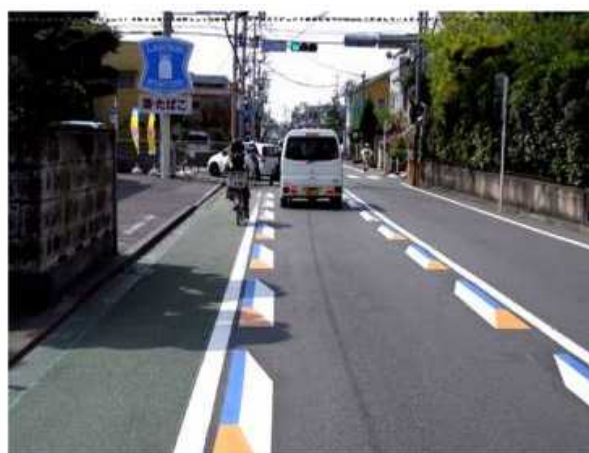
車道側に立体路面標示（茅ヶ崎地区）
