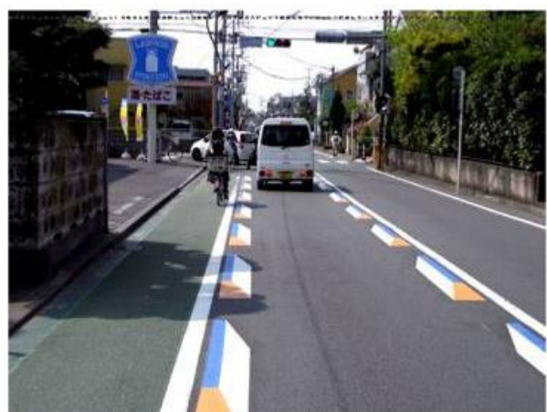
車道側に立体路面標示（茅ヶ崎地区）
