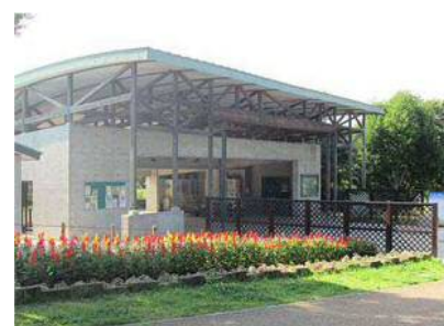
火災前の状況
