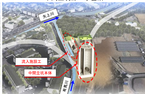
中間立坑部工事箇所
