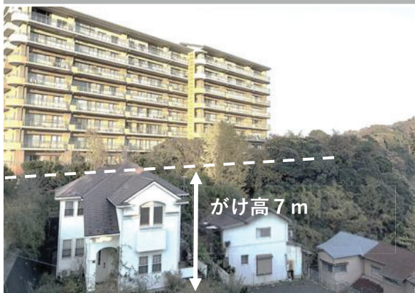
吉倉町地区（横須賀市）：R6工事实施
