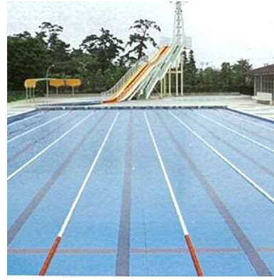
▲ 寒川町 町営プール
