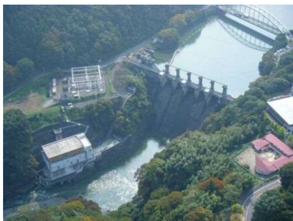
相模ダムと相模発電所
