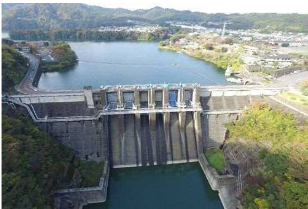
▲ 城山ダムと貯水池
