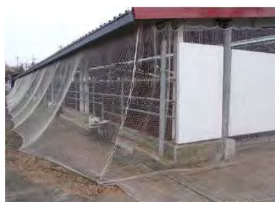
防鳥ネットの補修
