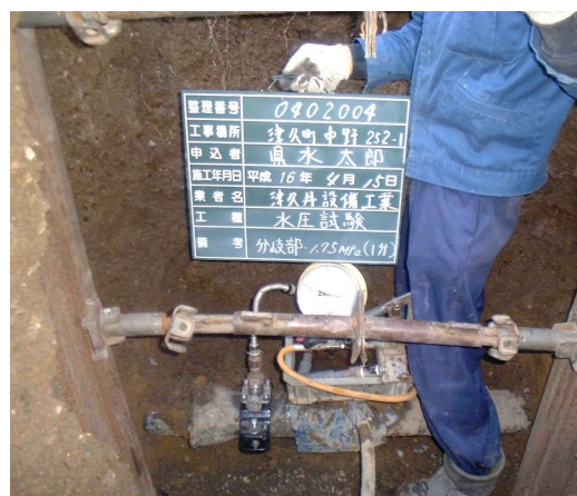
④ 水圧試験（分岐部）
