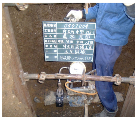
④ 水圧試験（分岐部）
