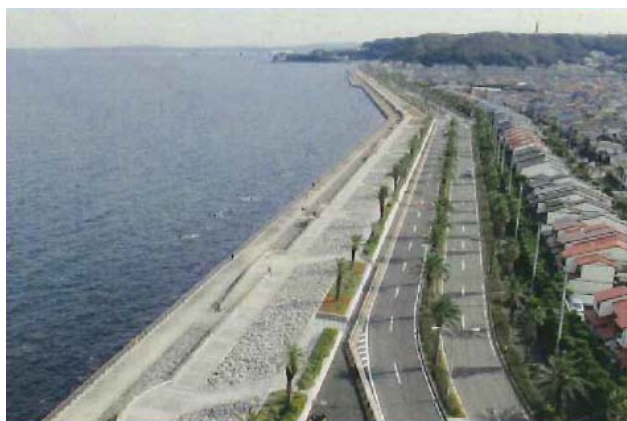
馬堀海岸（高潮対策護岸）
