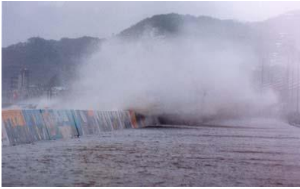
1995（平成 7）年 9 月の台風 12 号による越波 【横須賀港海岸馬堀地区】（出典：神奈川新聞社）
