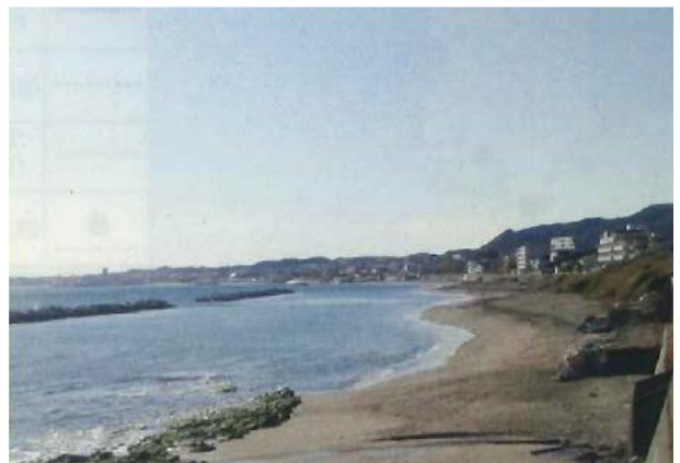
野比海岸（侵食対策の離岸堤）
