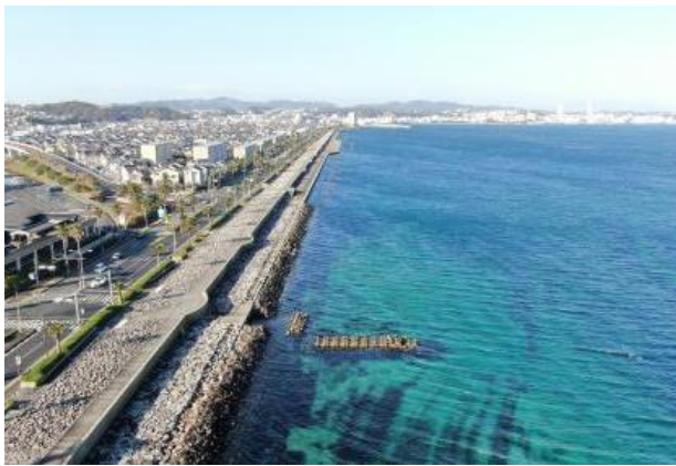
馬堀海岸（高潮対策護岸）
