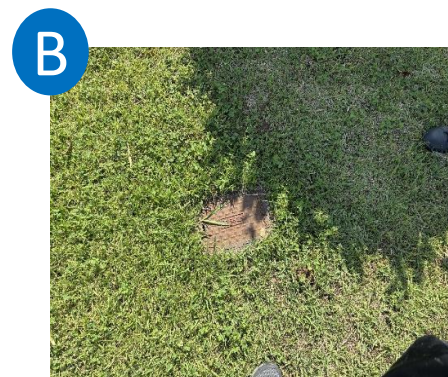
出入り口付近の散水栓
