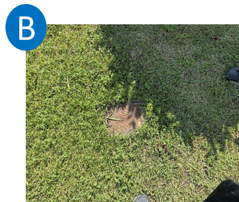
出入り口付近の散水栓
