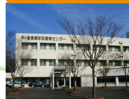
循環器呼吸器病センター
